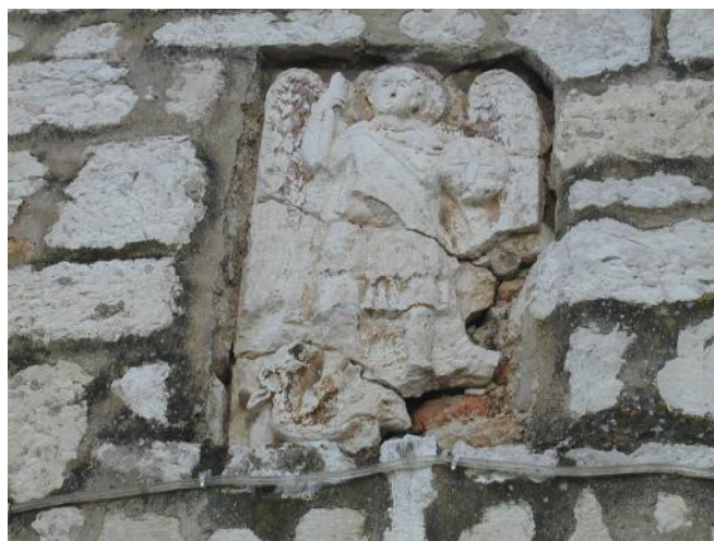
Stanje prije restauratorskih radova
