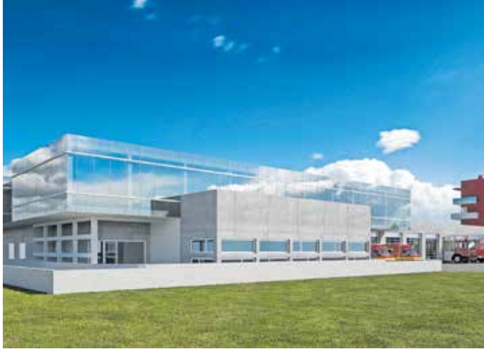
SASTOJI SE OD podruma, prizemlja i 1. kata, dok vatrogasni toranj ima četiri kata
