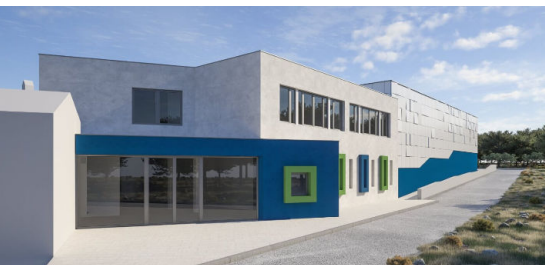
Rekonstrukcija Osnovne škole Brodarica
